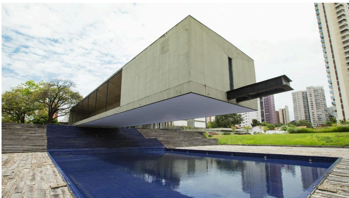
Estrutura do Mausoléu Castelo Branco
