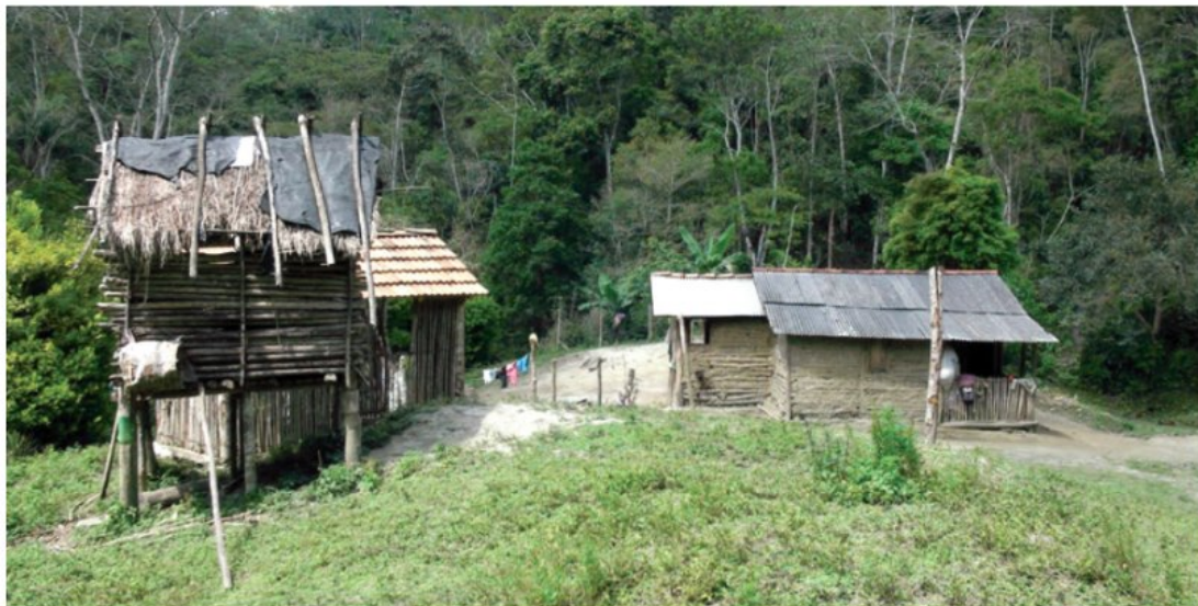
Casa de pau a pique do quilombo Bombas, em Iporanga (SP)
