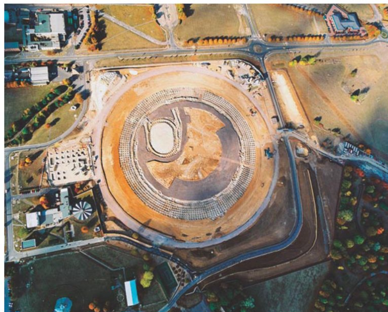
Figura 5. Pilares e colchão de concreto da estrutura do Diamond em novembro de 2003
