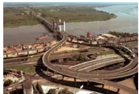
Figura 1.2 - Ponte sobre o Rio Guaíba, Porto Alegre - Rio Grande do Sul.
