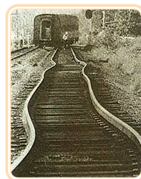
Figura 2.1: Esta figura mostra uma estrada férrea que sofreu uma dilatação maior do que a que seria possível. Você consegue pensar em alguma situação que tenha causado esta dilatação irregular?
