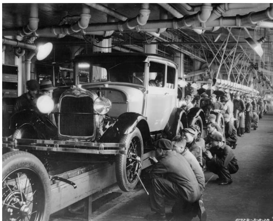
Operários trabalham na linha de montagem de veículos em fábrica da Ford Motor Company, nos EUA, em 1928.
