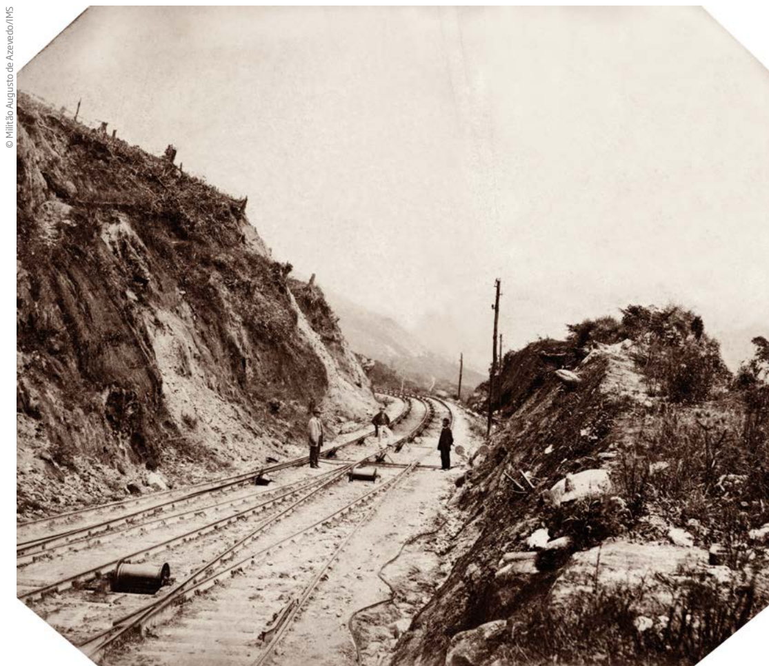
Construção da estrada de ferro Santos-Jundiaí, em 1864.
