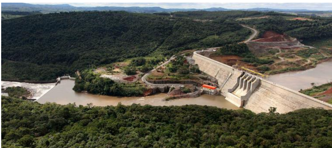
Figura 14: Usina hidrelétrica Mauá
