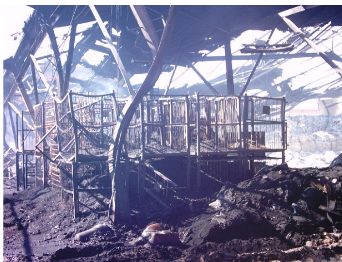
Fig. 3-11 Comportamento do aço ao fogo
