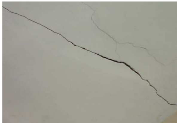
Fig. 3-4 Rachadura
