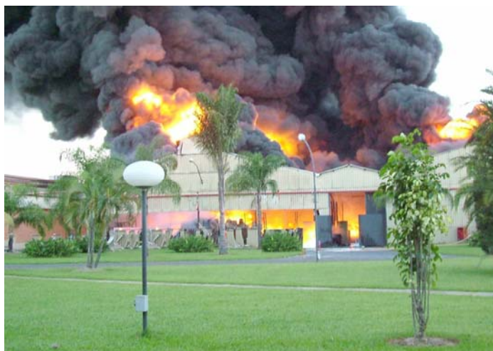
Fig. 3-10 Estrutura em risco
