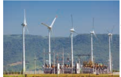
Parque eólico de Osório (RS).
