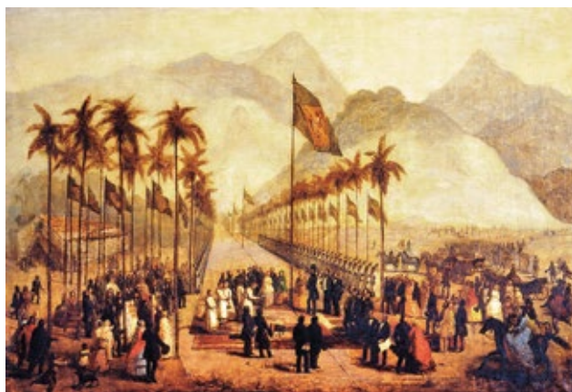
Lançamento da pedra fundamental da Estrada de Ferro Mauá, realizado no dia 30 de abril de 1854, na localidade de Fragoso, em Magé (RJ).
