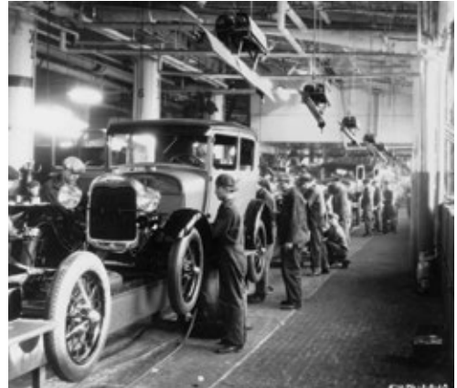
Esteiras e trilhos aéreos com peças que abasteciam as linhas de montagem nas indústrias que adotavam o modelo fordista.
